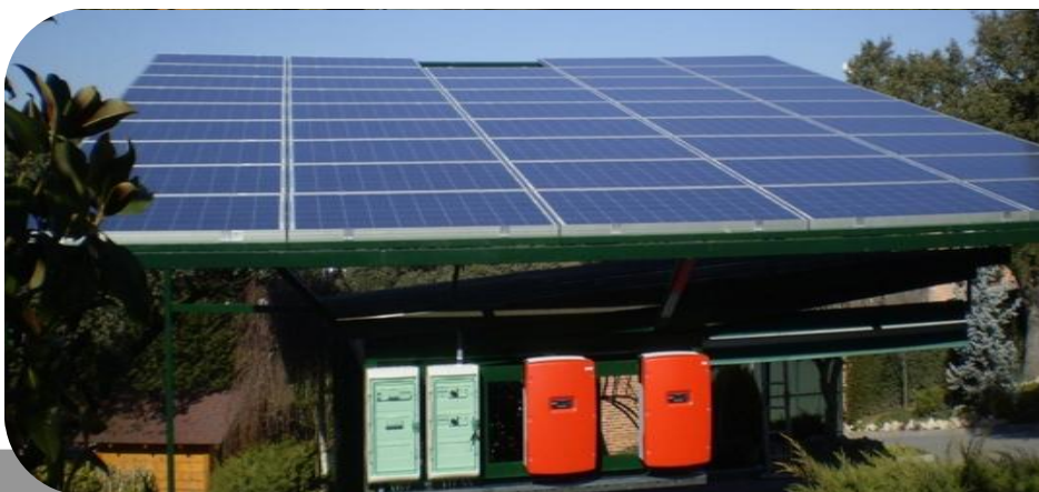
Instalación Solar Fotovoltaica de 9,2 kW sobre cubierta de parking
