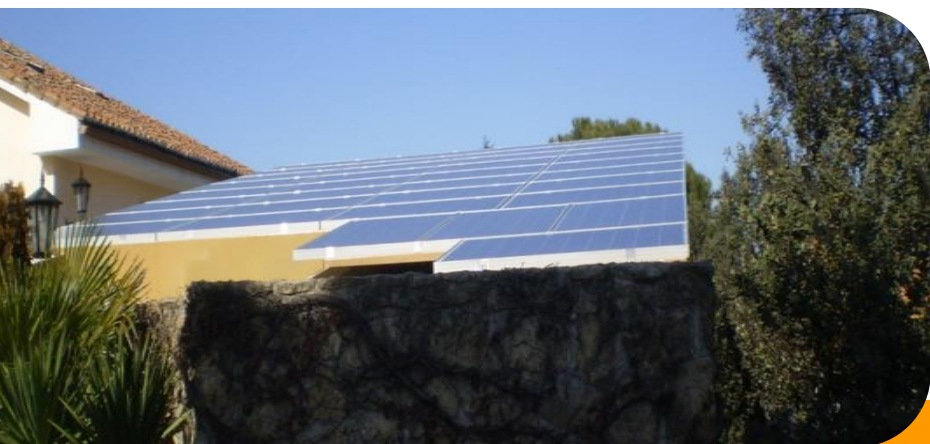
Instalación Solar Fotovoltaica de 7,4 kW sobre cubierta de parking
