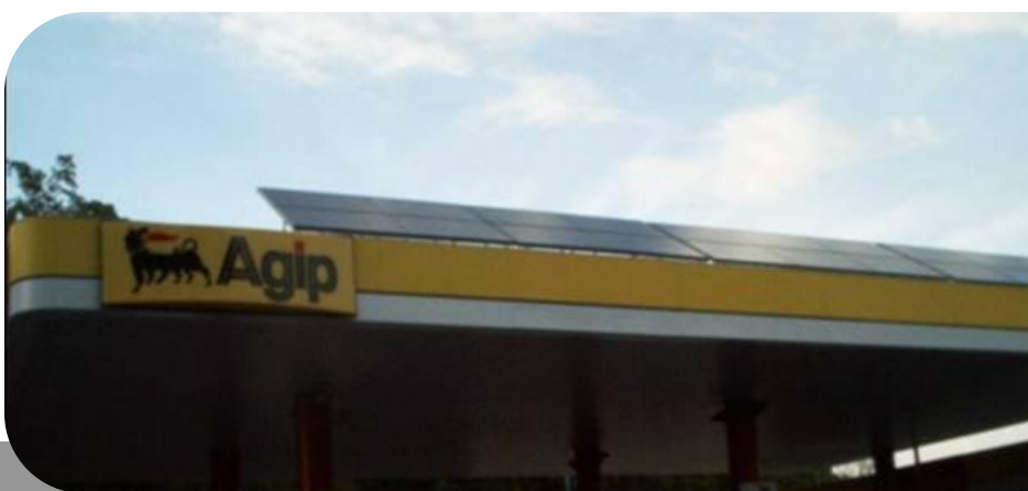
Instalación Solar Fotovoltaica de 10 kW sobre cubierta de gasolinera
