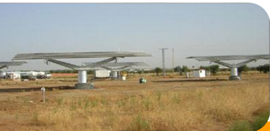
Parque Solar Fotovoltaico de 100 kW con seguimiento a dos ejes
