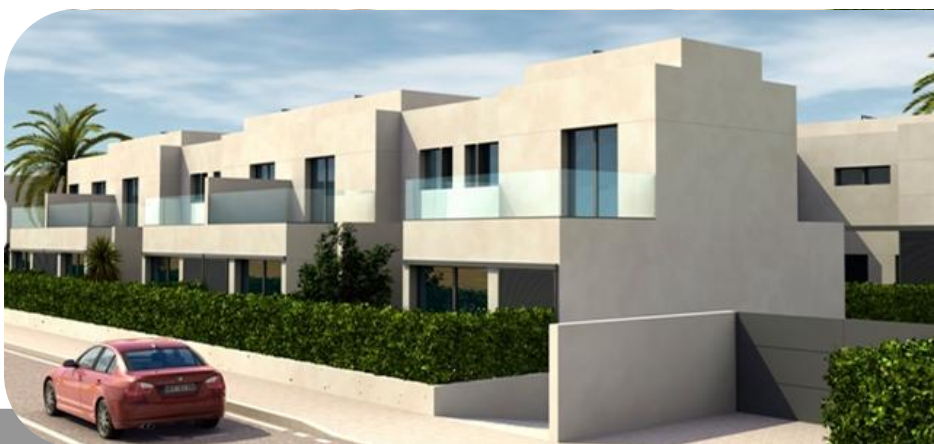
Energía Solar Térmica 29 viviendas unifamiliares
