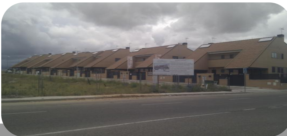
Energía Solar Térmica 33 viviendas unifamiliares
