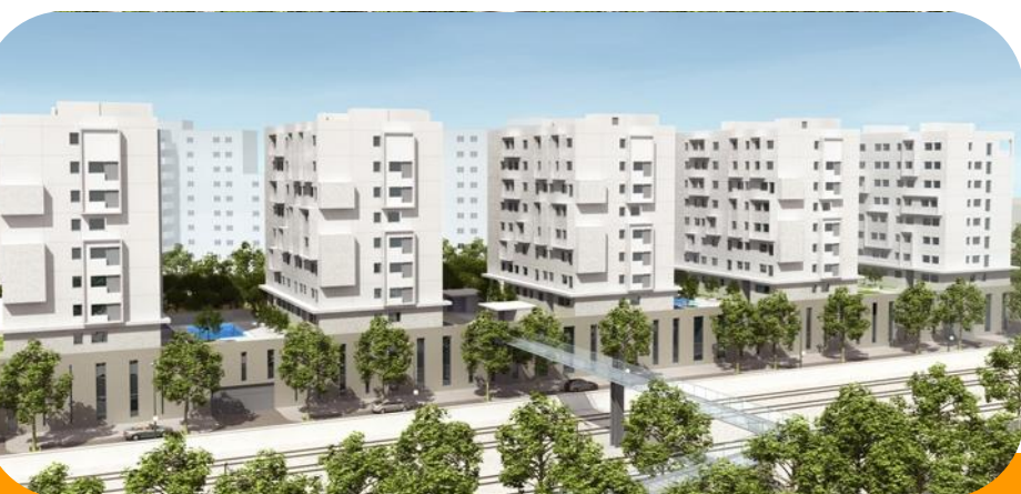
Energía Solar Térmica 151 viviendas multifamiliares
